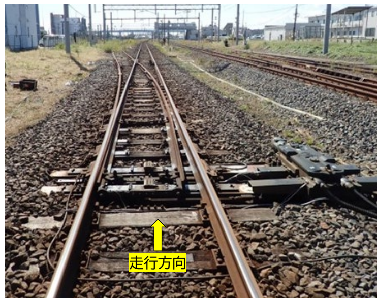
図3-1 試験対象分岐器の状況
