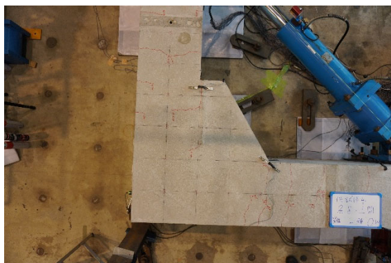
写真-4.6 1\delta y の損傷状況（供試体 N）
