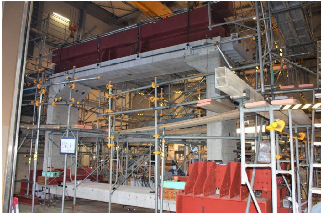
写真-2.2 実験機材等の組立て完了状況
