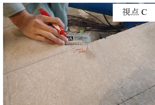
写真-4.4 側壁ハンチ下部ひび割れ発生時
