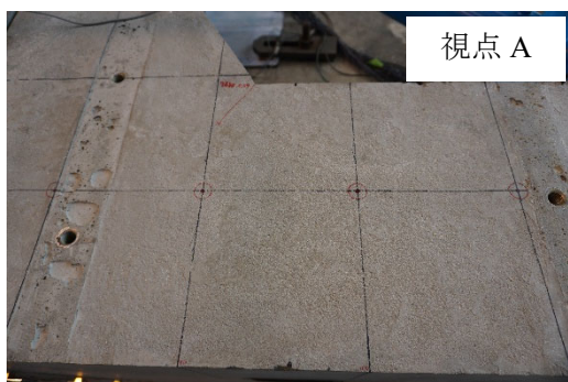
写真－6.1 側壁ハンチ下部ひび割れ発生時
