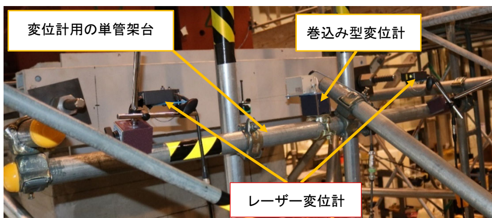
写真-2.7 変位3（巻込み型変位計）と変位4, 5（レーザー変位計）の設置状況
