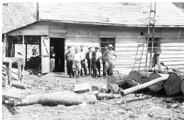
図 4-13 林内に設置された造材飯場
