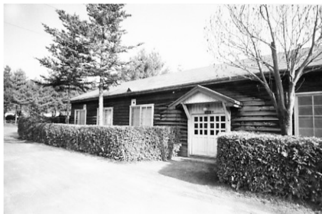
図2-7 旧学生宿舎（1951年建設）
