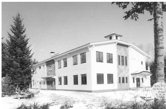
図 2-22 1979年に建設された現在の研究棟および学生宿舎
