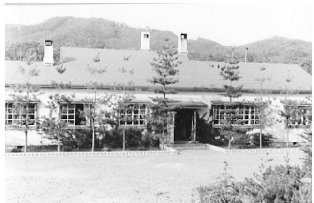
図 2-21 1961 年に改築された旧事務所
