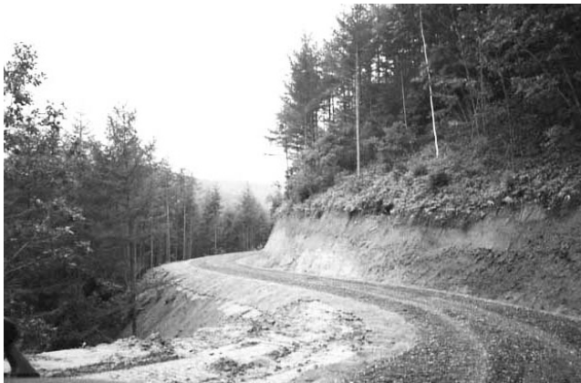
図3-12 職員による“自力”で開設された縦貫林道(23林班, 1989年)
