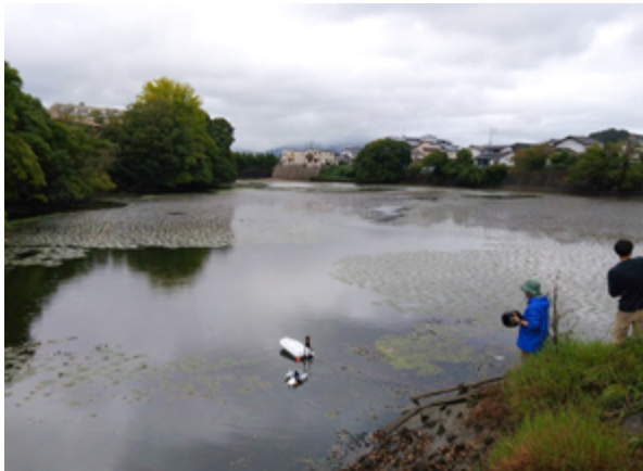
写真1：農業用ため池における測量調査の様子
