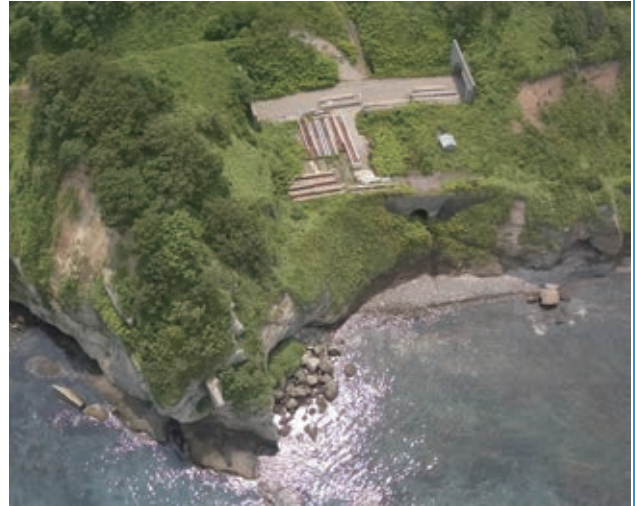
▲ 笠岩・塩谷廃トンネル跡（ドローン撮影）
