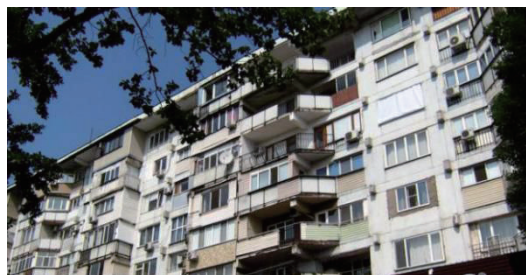
（写真 18）9 階建て集合住宅（筆者撮影）
