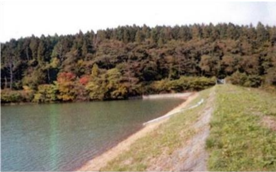
写真 4. 不動池堰堤（著者撮影）
