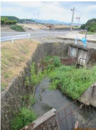
写真 3. 雷山川から大溜池への取水口：写真右下の雷山川から上方に続く水路から取水。（2025 年 9 月，磯望撮影）
