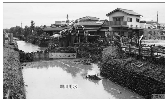
写真 3-6 被災した菱野の三連水車
