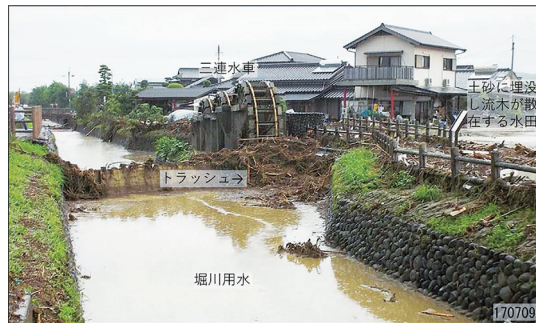
写真 3-6 被災した菱野の三連水車
