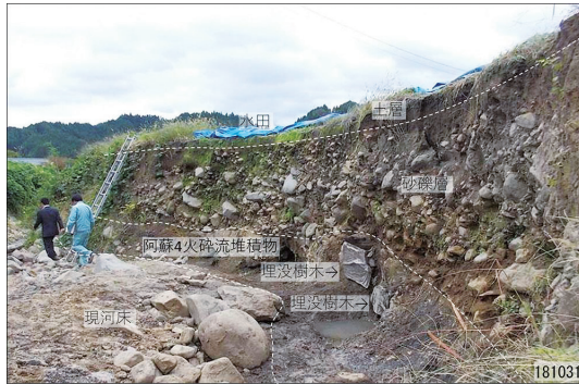
写真 3-9 埋没樹木が出現した露頭
