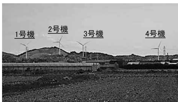
図2 現場の写真(著者の一人が北西側から撮影)
