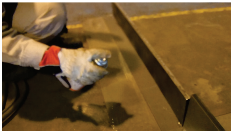
Fig. 5-4 Zinc rich primer painting
