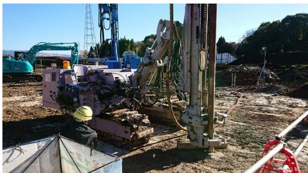
図 4.5.7 測定孔の造成
