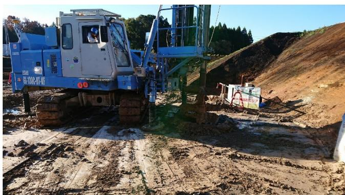
図 4.5.5 機械攪拌改良工法（GI コラム工法）による地盤改良の様子
