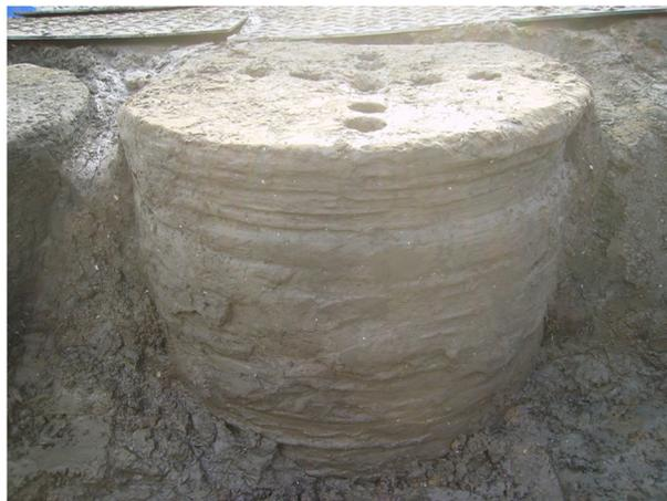
図 1.1.9 機械攪拌工法で造成した円柱改良体<sup>13)</sup>
