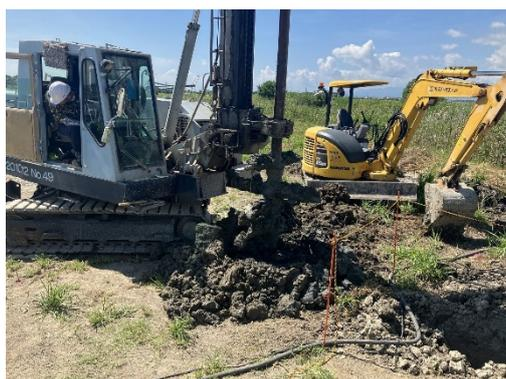
図 4.5.10 機械攪拌改良工法（テノコラム工法）による地盤改良の様子
