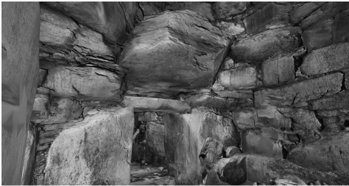
図12 童男山1号墳の玄門袖石・天井石周辺(玄室奥壁側から)
