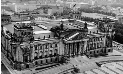
【図4】壁崩壊前（1986年）
