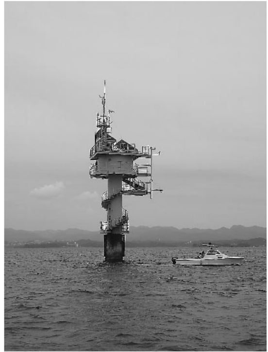
Fig. 2 京都大学防災研究所の観測タワー。田辺湾口の沖合 2km 地点（水深 10m）に固定された塔で、海面に向けて超音波式の水位計測をしている（白浜海象観測所のホームページより）。
