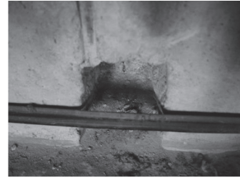
Fig.13 Trou de boulin (putlog hole)
