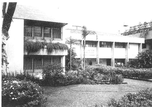
写真: IICS 新館実験棟の全景
