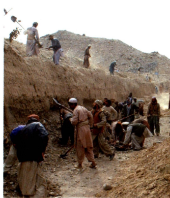
2003年12月 用水路掘削作業
