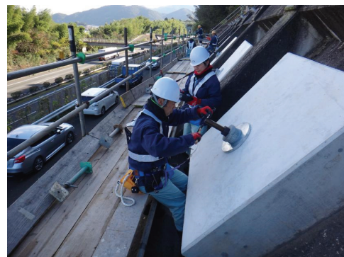
写真-2 のり面における現地計測状況例
