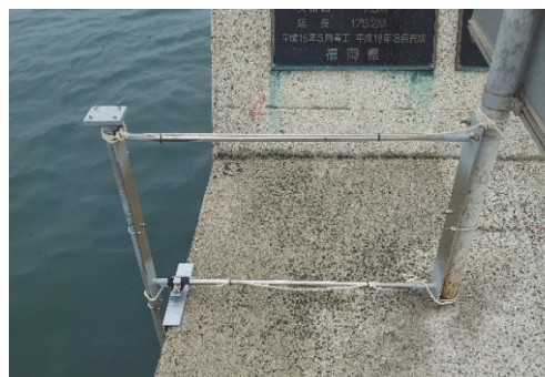
図 8 水位計を設置した様子（津屋崎）
