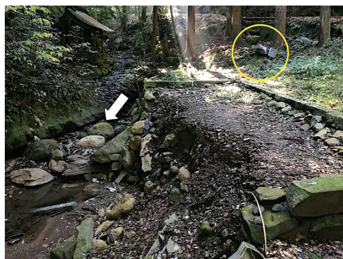
写真10 白岩地区 (No. 13) の土石流の痕跡 (丸が水神跡、矢印は河川の流下方向)
