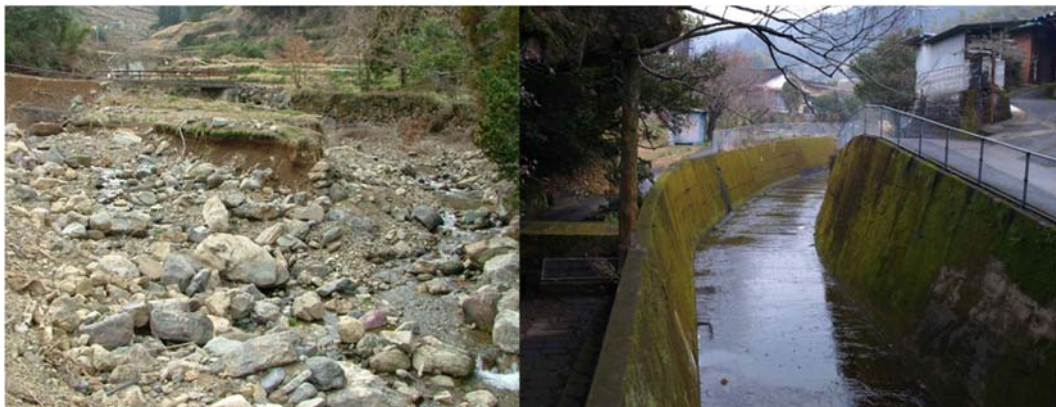
図 1.1.1 被災時の山地河川の様子（左）一般的な改修後の山地河川（右）
