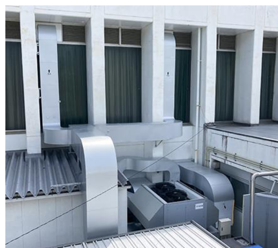
図 2.2 給気・熱回収ダクト [6]
