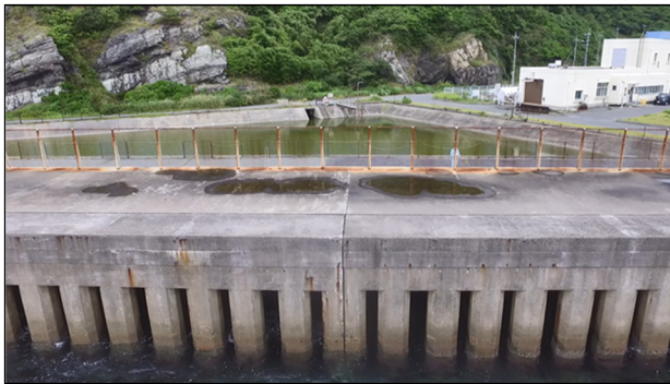
写真-1 スリット式直立消波護岸
