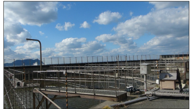
写真-3 沈砂池内の観測用足場
