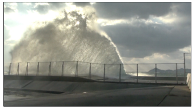
写真-2 観測時の越波の状況
