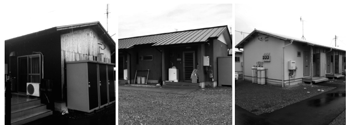
Photo 2 3 types of timber temporary housings in Kumamoto 熊本で整備された 3 種類の木造仮設住宅 注 1)
