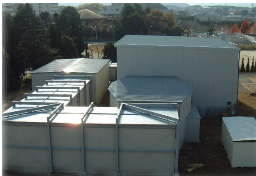
Fig. 3.12 九州大学応用力学研究所大型境界層風洞の外観図 (引用 : https://www.riam.kyushu-u.ac.jp/offshorewind/equipment.html )
