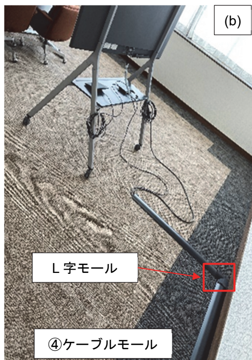
図 7 Neat 周辺環境 全体 (a) 作業前 (b) 作業後
