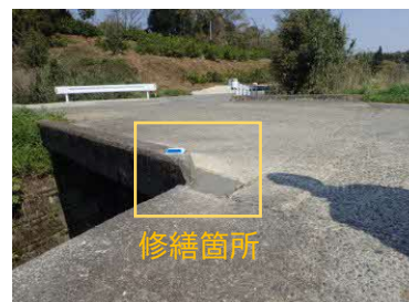
施工完了の状況
