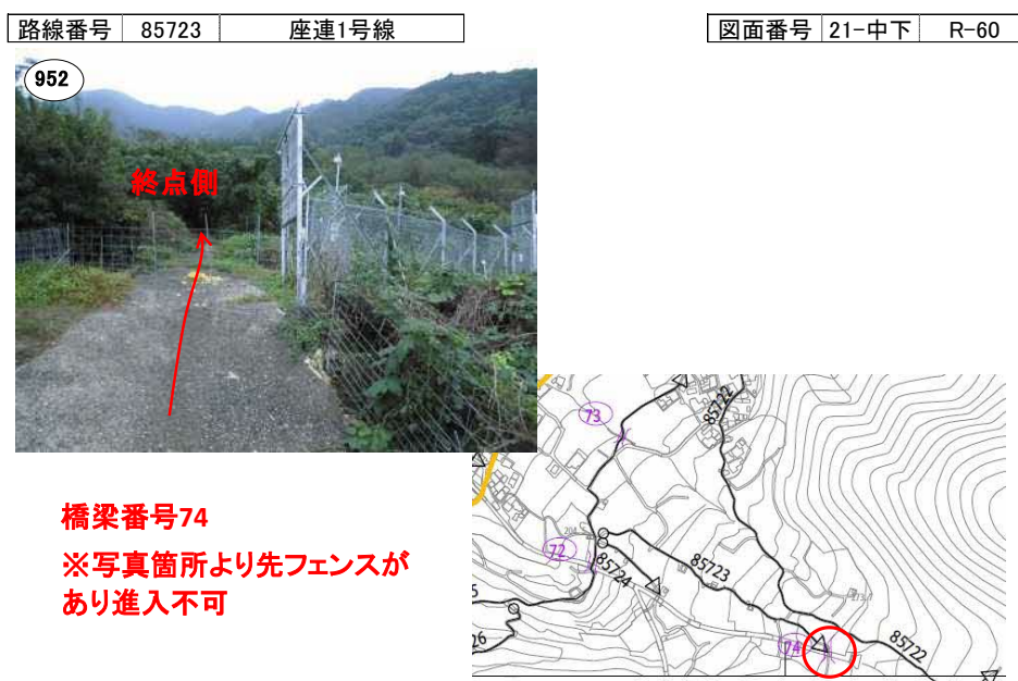
図-2.9 野生動物除けのフェンスにより市道を封鎖している状況
