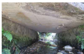
(a) 石積の上に RC スラブを載せた橋
