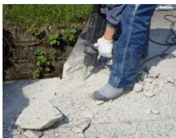
はつりの施工状況
