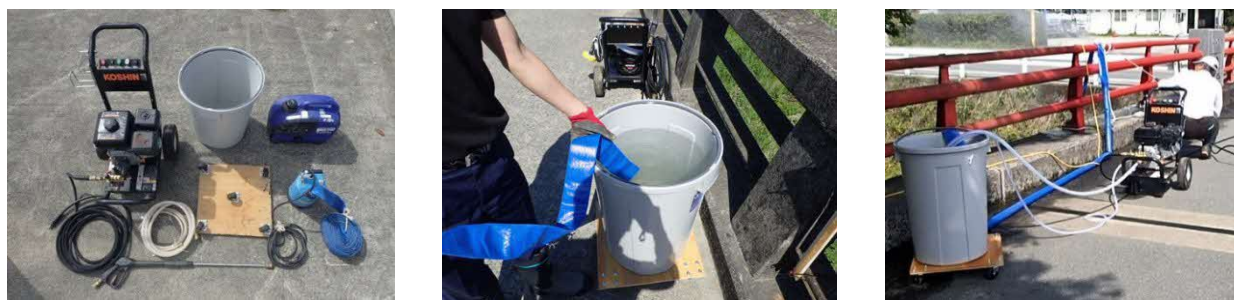
(a) 調達可能な材料や機材で編成した清掃セット (b) 現場で洗浄水を調達している状況 (c) 清掃セットを用いて清掃している状況
