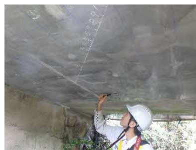
橋梁下面（補修面）での弾性波入力状況
