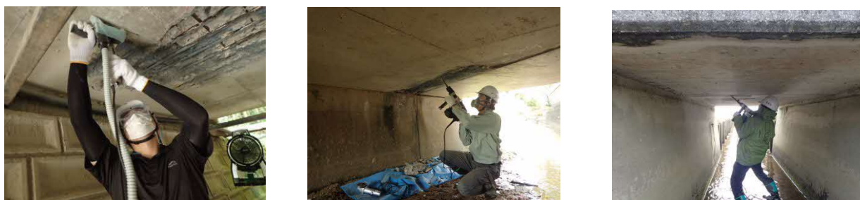
図－3.3 4 本市の職員によるはつり作業の状況
