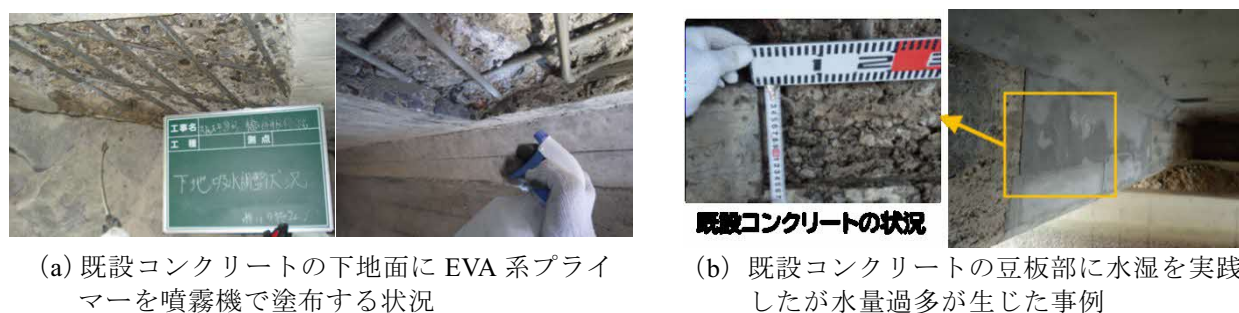
図-3.18 専門業者の施工現場の調査状況
