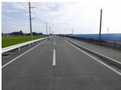
(a) 橋面の状況
