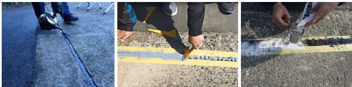
加熱した材料による施工状況
