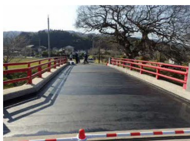
(a) 広福寺橋の施工状況
