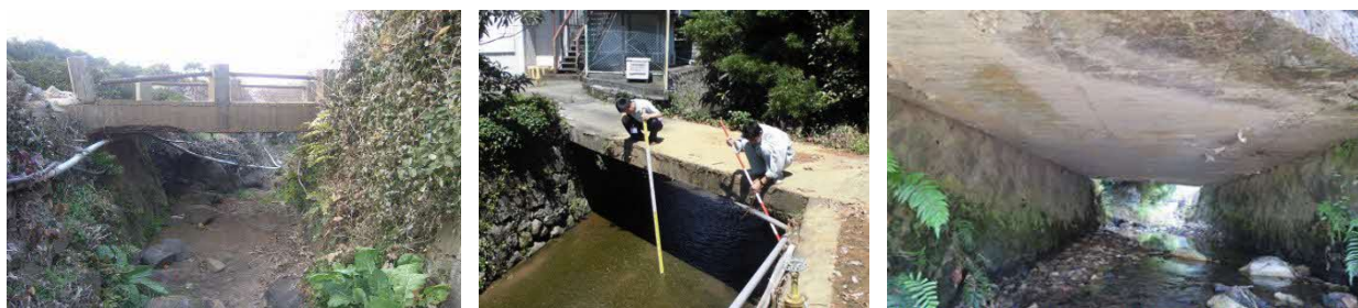
図－3.3 空石積の上にRCスラブが載る本市の市道橋の状況
