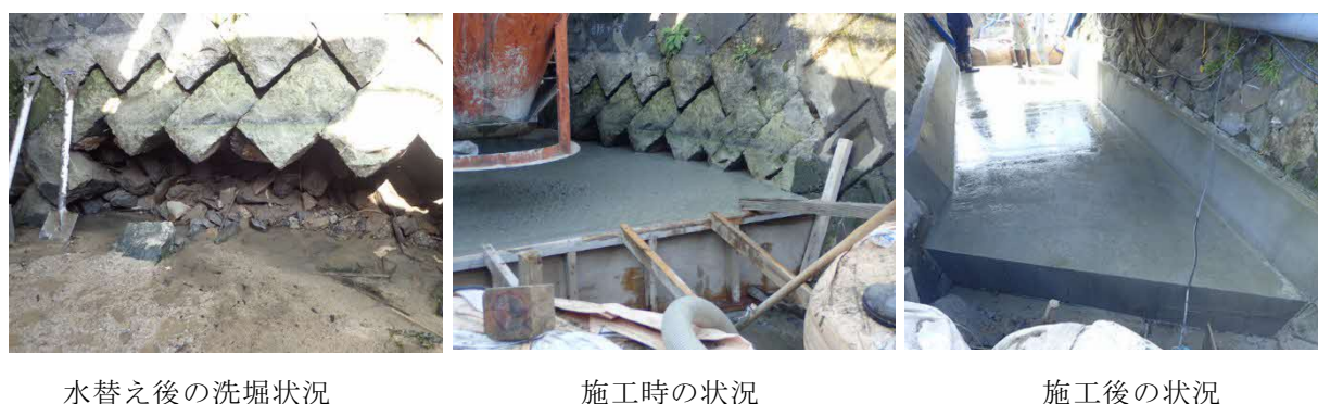
図－4.5 『分離発注』によって早急な洗堀対策を実践した状況
