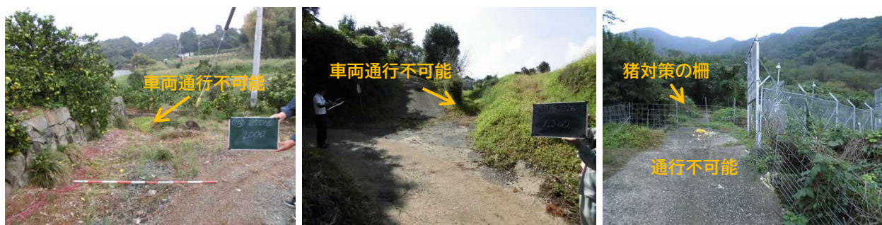
図－3.4 車両が通行できない本市の市道の状況
