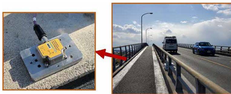
図－6.4 小島橋におけるセンサの設置状況
