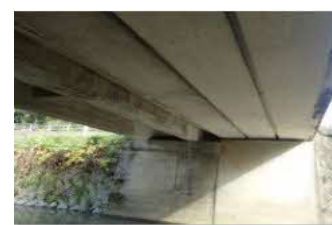
(c) RCT 桁橋を PC の床版橋で拡幅した橋
