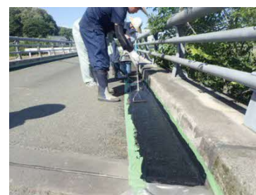
(c) 中島橋の施工状況
