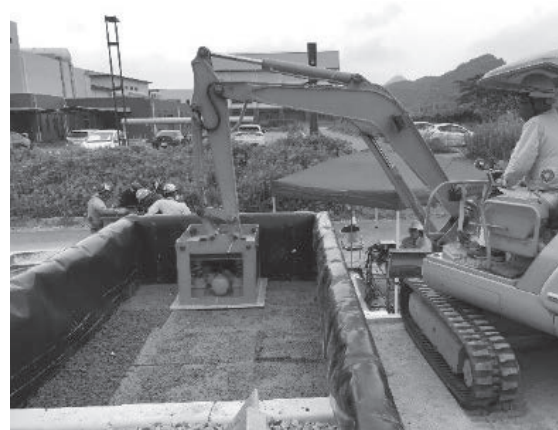
図 2 固化式処分の実証施工
