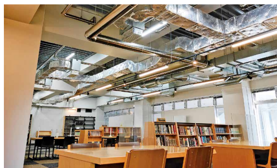
改修後の閲覧室
