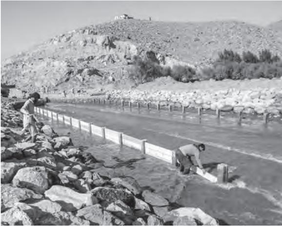
PMS職員達が考案した沈砂池の排砂設備。(2015年12月)
