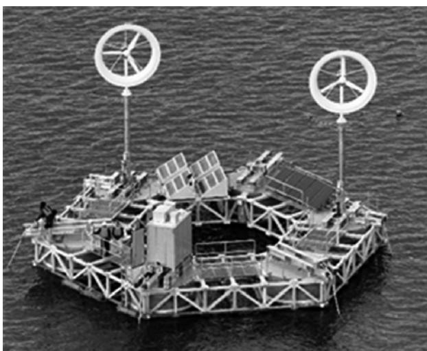
図-7 海上設置後の浮体発電施設
