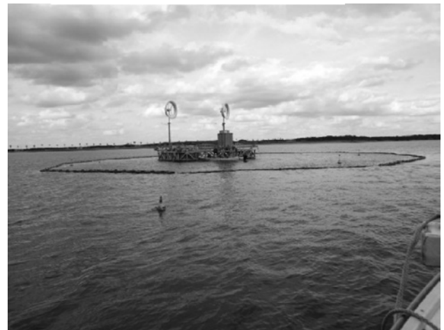
図-4 浮体導入後 2011.12.4
