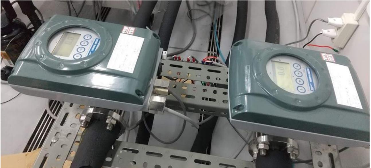
図 2.2.3.b 電磁流量計
