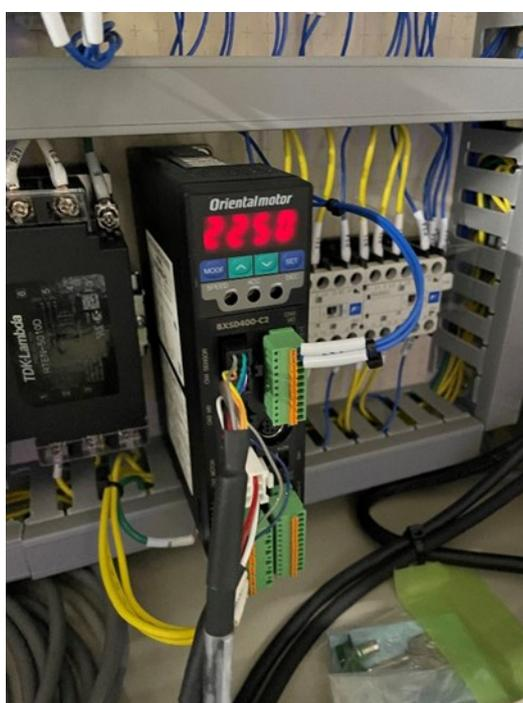
図 4.63 ピッチ動揺の周期を変更する際に設定する制御盤内の数値
