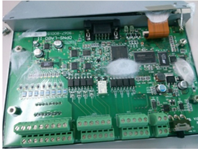
観測箱に侵入したクモが基板上に巣をつくったため、回路がショートし、修理不能となったネットワークデータロガー
