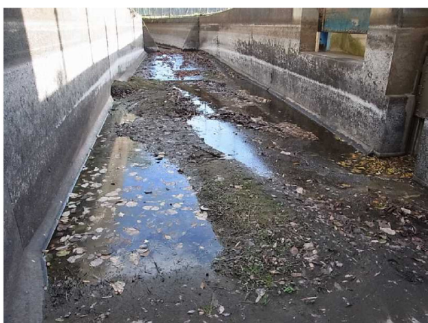
(a) 地点 B 余水吐掘込部の堆積状況
