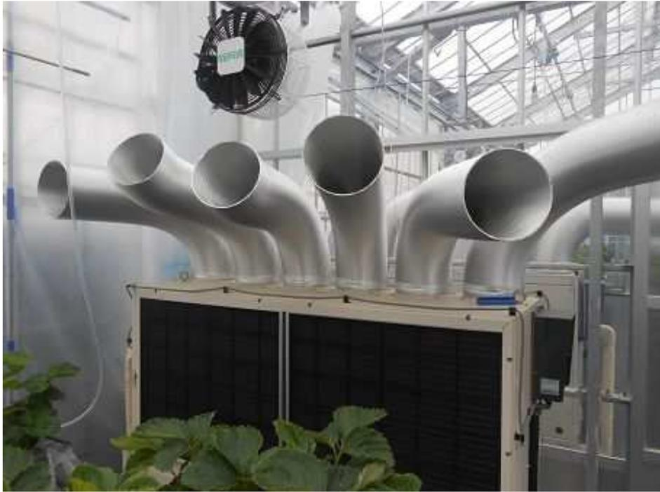
図4-1 日中加温試験に使用したヒートポンプ
