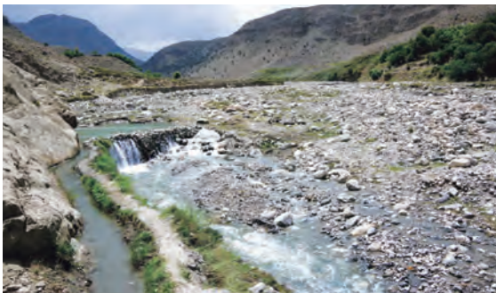
[左] コット川から下流の村まで引かれた既存の水路。これと同じ原理で、本計画では水量が増える夏季に川から取水する予定。[右] 年間を通して取水が見込まれる川沿い崖地の湧水。川と湧水からの取水によって、1本の用水路が引かれる。(2022年5月30日)
