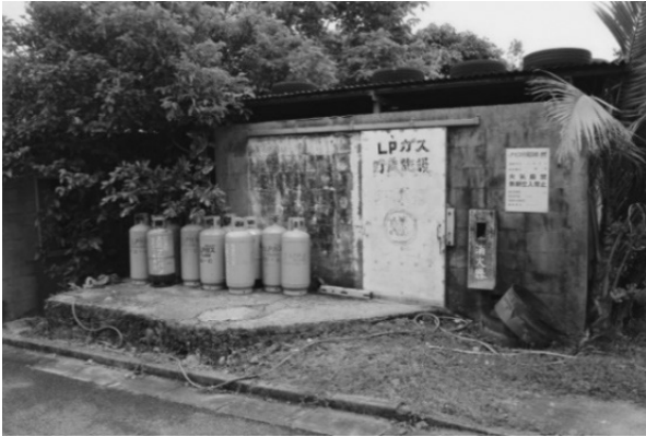
写真4 カク(檻)の跡地に造られたLPガス貯蔵施設。西表島南東部。2021年。
