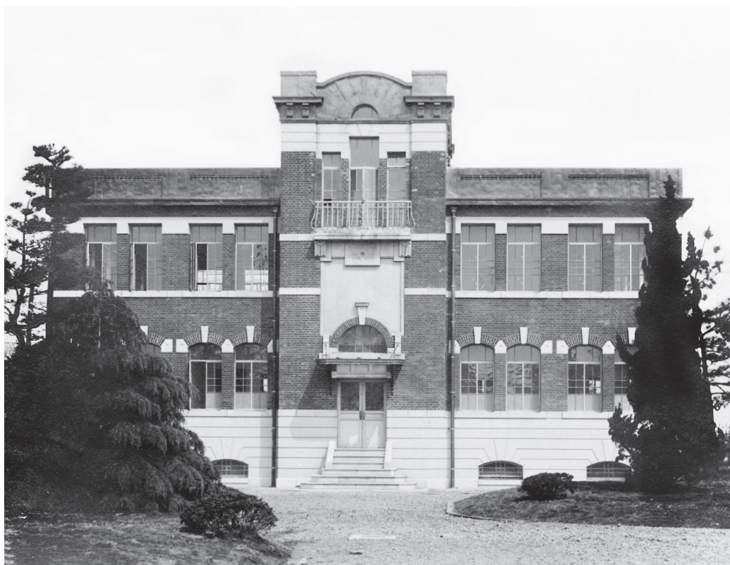
「仮実験室研究室第一附属屋」（大正14年）
