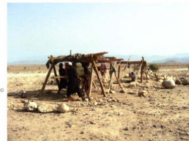
井戸掘り作業現場
