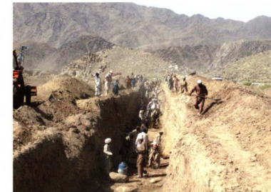
掘削中の用水路
