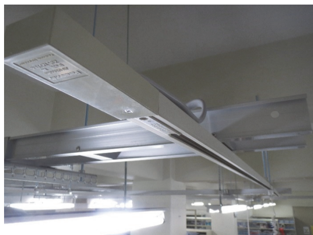
図 3 小規模分岐用配管ダクト
