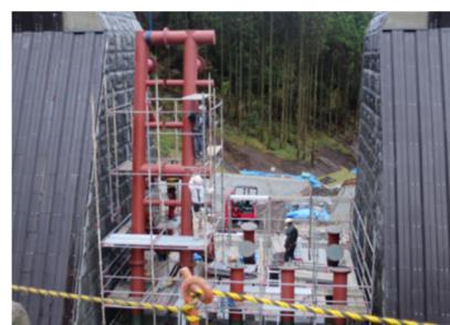
写真-2 鋼製堰堤の現地組立状況
