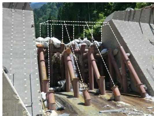
写真-1 土石流による鋼製堰堤の被災事例
