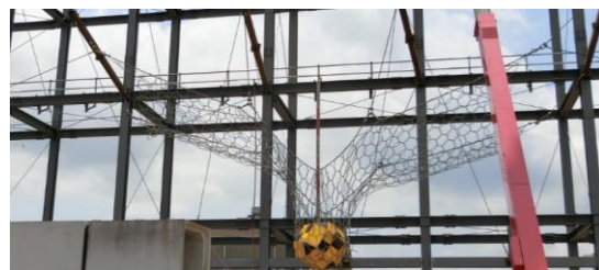
写真-2 実物大ワイヤリング防護柵供試体
