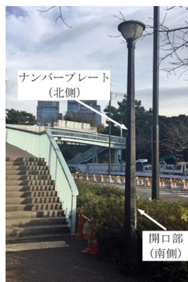
図 5-2 調査対象とした照明柱の設置状況
