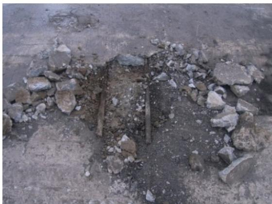
写真-1.3 床版上面の土砂化
