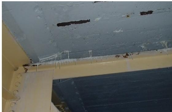
写真-1.2 床版下面の漏水
