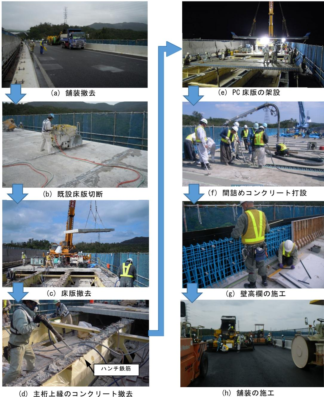
写真-2.2 床版取替えの施工手順
