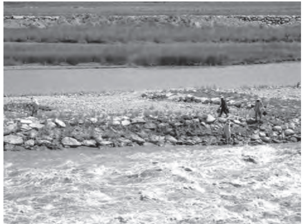
バルカシコートの砂州1で水やりをしている作業員たち。水やりは根気あるのみ。(2021年6月20日)
