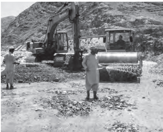
築堤工事。水を撒き、ローラーで締め固めを行う。（2021年6月29日）
