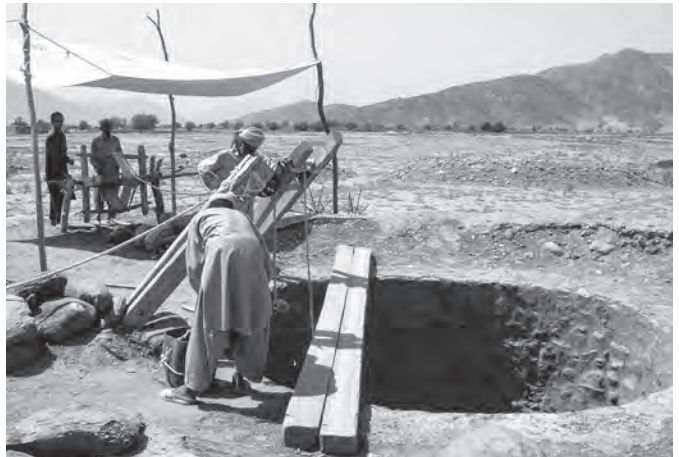
ダラエヌール渓谷で灌漑用井戸を掘削している様子。奥に見えるのは干ばつにより渴ききった畑。（2003年8月27日）
