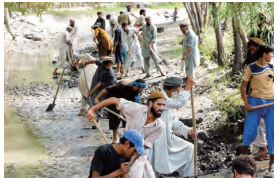
H地区用水路の住民による浚渫作業。用水路維持保全の継続は建設以上の労力を要する。浚渫された泥土は貴重品で、有機質を多量に含む。近傍に置けば、住民が喜んで持ち帰り、田畑に入れる (2012年9月9日)
