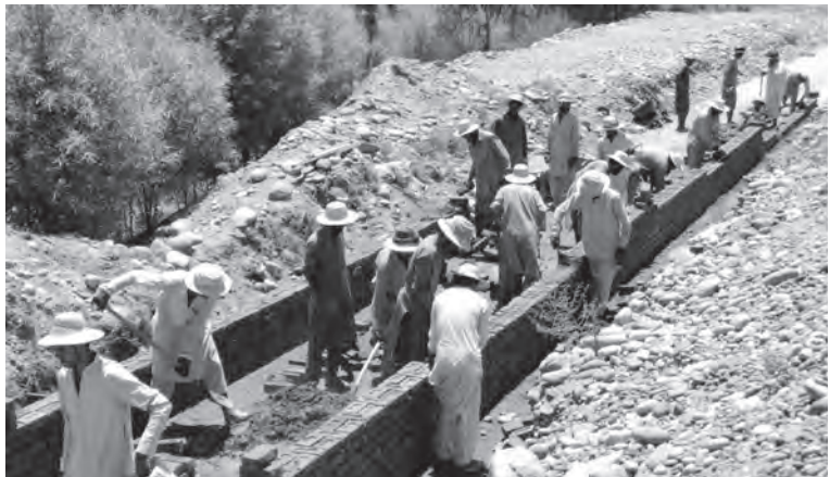
新ペラ用水路延長工事。気温が40度を超える中、50人ほどの作業員が懸命に働いている(2020年7月2日)
