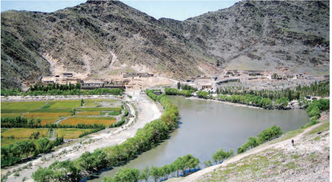
マルワリード用水路 H2緩衝池。長さ180m、幅30~80m。写真右側には渓谷からの土石流を緩流化させるため、ユーカリの植林を施している (2009年4月23日)
