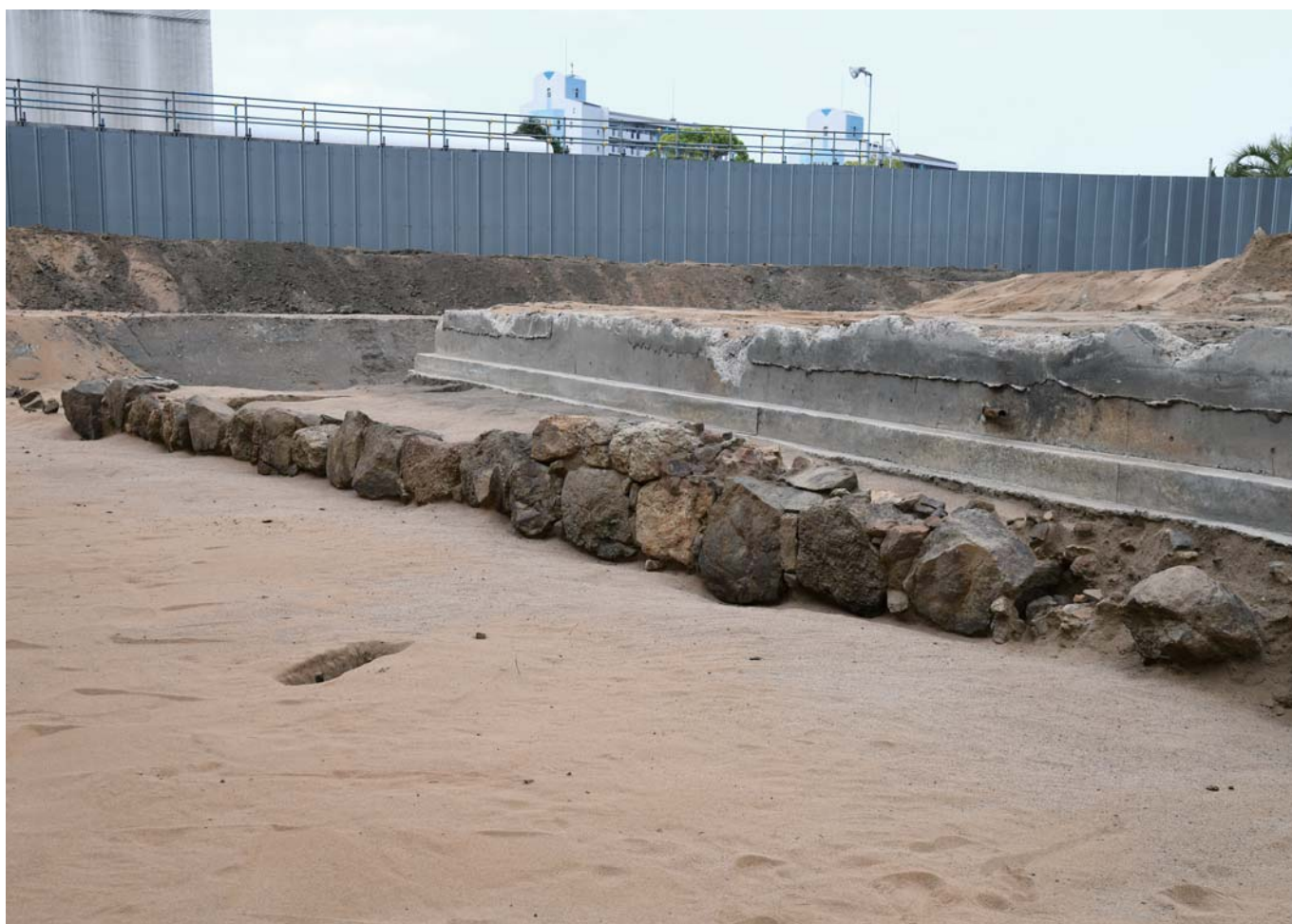
HZK1805地点 石積み遺構 SF00 (南西から)
