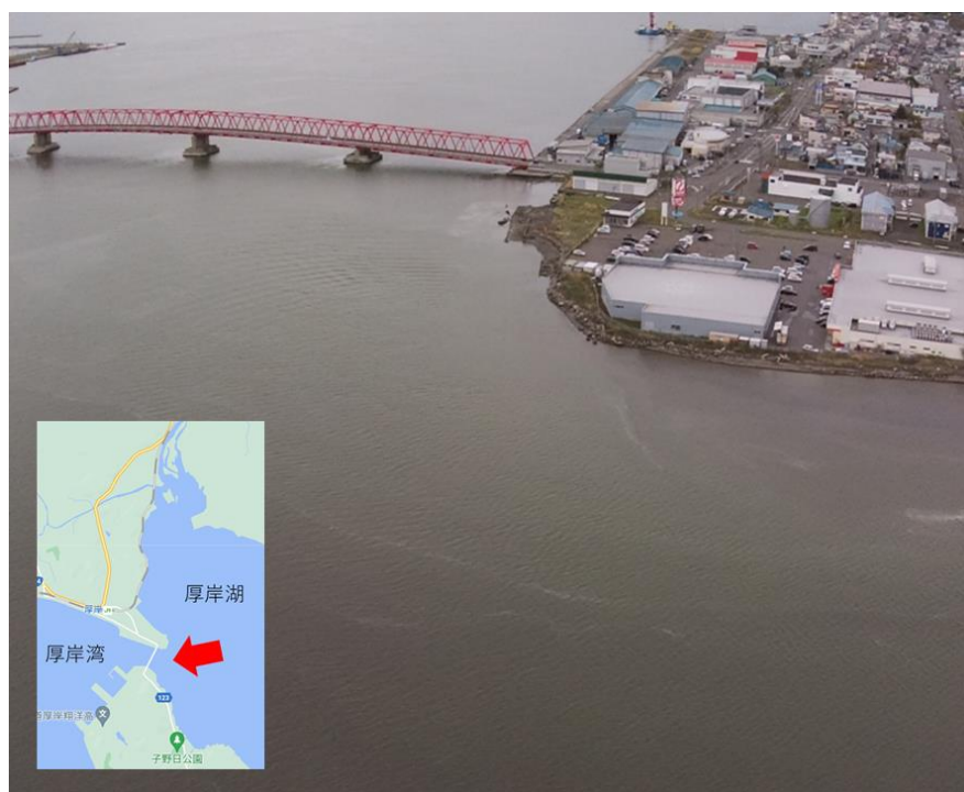
図 4.1.2 厚岸湾大橋の河川フロントを上空から斜め方向に見下ろした空撮画像。左下図の矢印は撮影した位置と方向。(地図は Google Maps( https://www.google.co.jp/maps/ )より)
